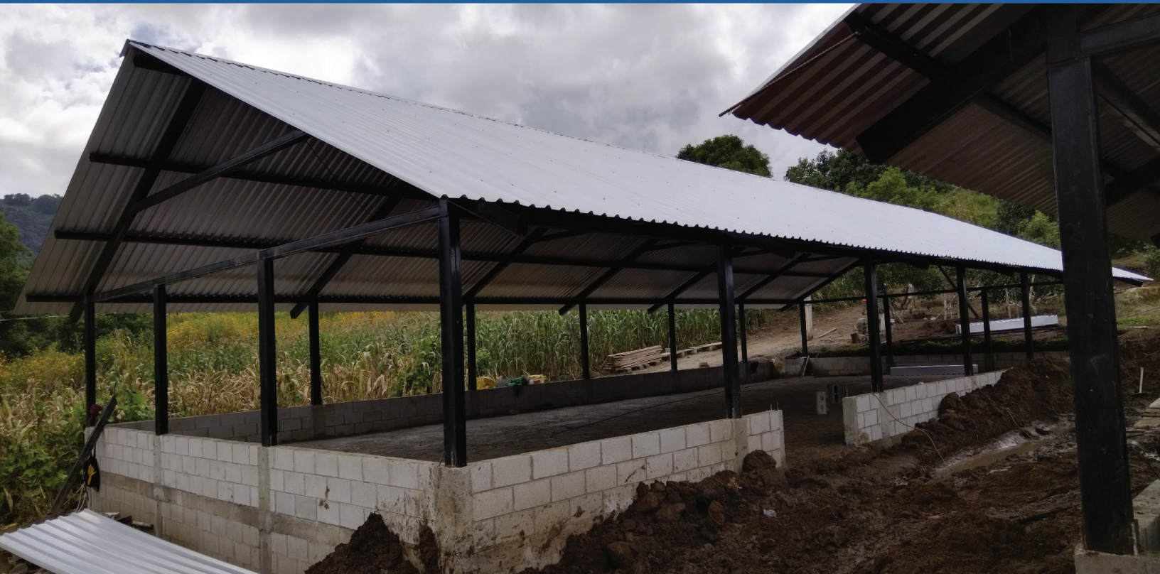
Imagen 6. Verificación de la construcción de granja avícola de la Cooperativa Mujeres de Occidente, en San Andrés Semetabaj, Sololá
